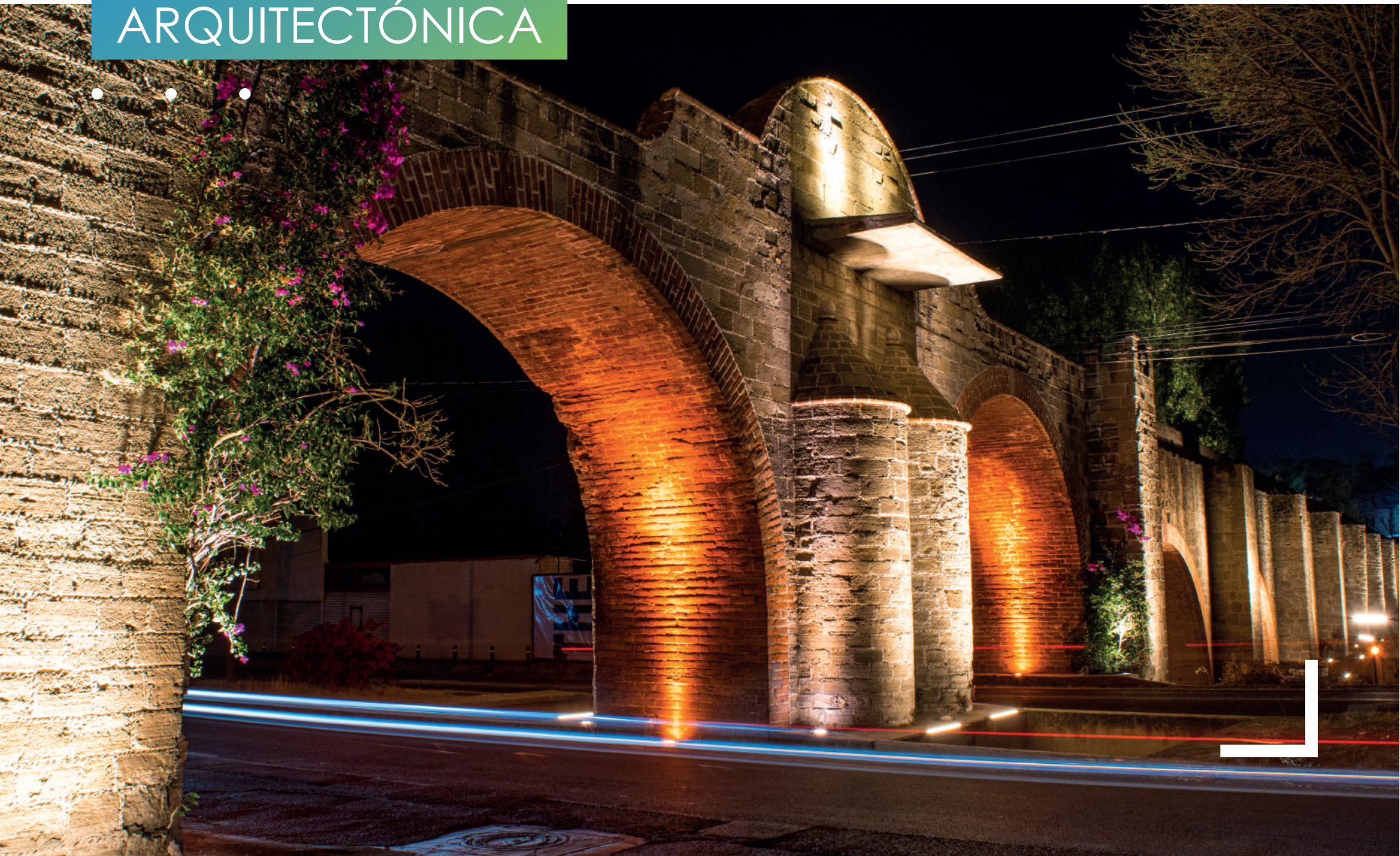
ACUEDUCTO ATEMPAN, TLAXCALA
